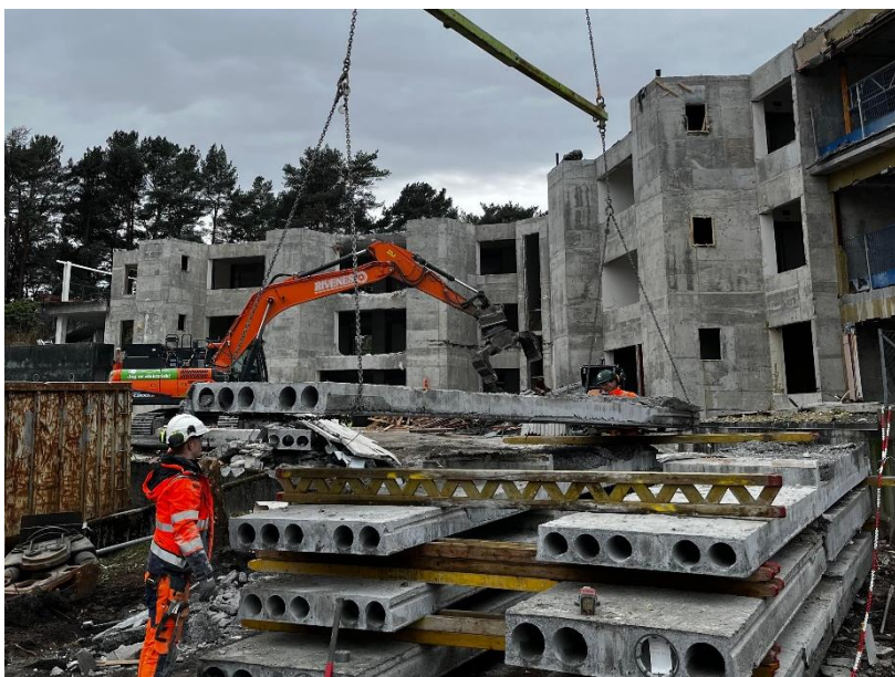
Bilde 3 - Demontert hulldekke som heises ned
