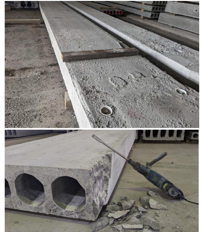
Figur 3 Fjerning av fugestøp fra utsagede hulldekker fra Volda Symjehall, 2023 (foto: Vegard Alme Ulstein, Spenncon)
